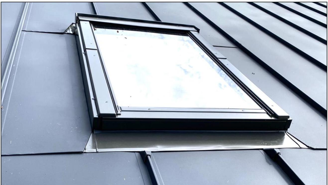
В этом примере дополнительные панели заведены на раму окна без применения боковых деталей фартука, а под нижней деталью фартука применены «заглушки гребней» (Подробнее про изготовление заглушек гребней в приложении 3).
