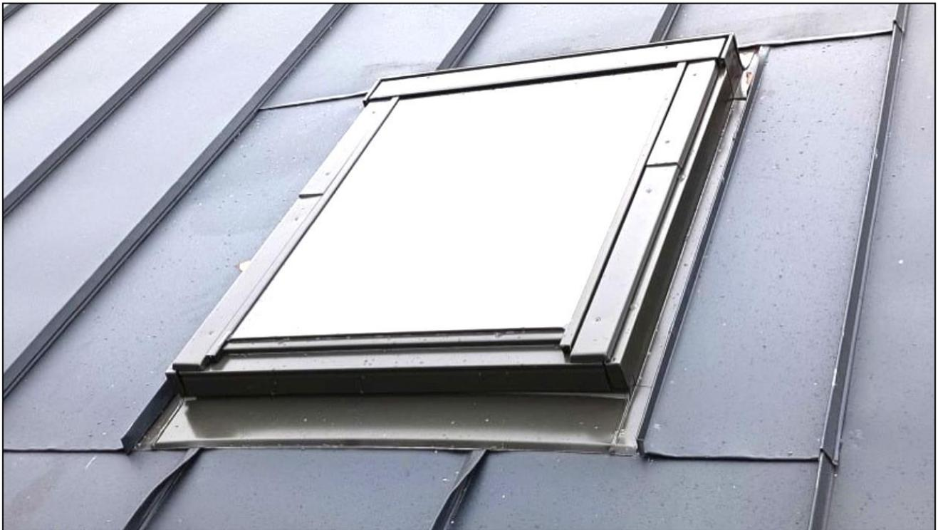
В этом примере дополнительные панели соединены с боковыми деталями фартука, а под нижней деталью фартука проведено «аккуратное заваливание» гребней кровельных панелей (подробнее- в приложении 3)
