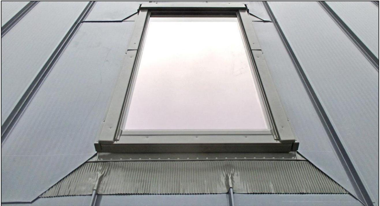
На фото пример монтажа «по мотивам» инструкции производителя в части «косых» разделок, а именно нижняя правая по инструкции производителя мансардных окон, а нижняя левая с добавлением горизонтального участка, что позволило не сильно опускать «косую линию» разделки. В верхней части обе стороны сделаны с добавлением горизонтального участка.
